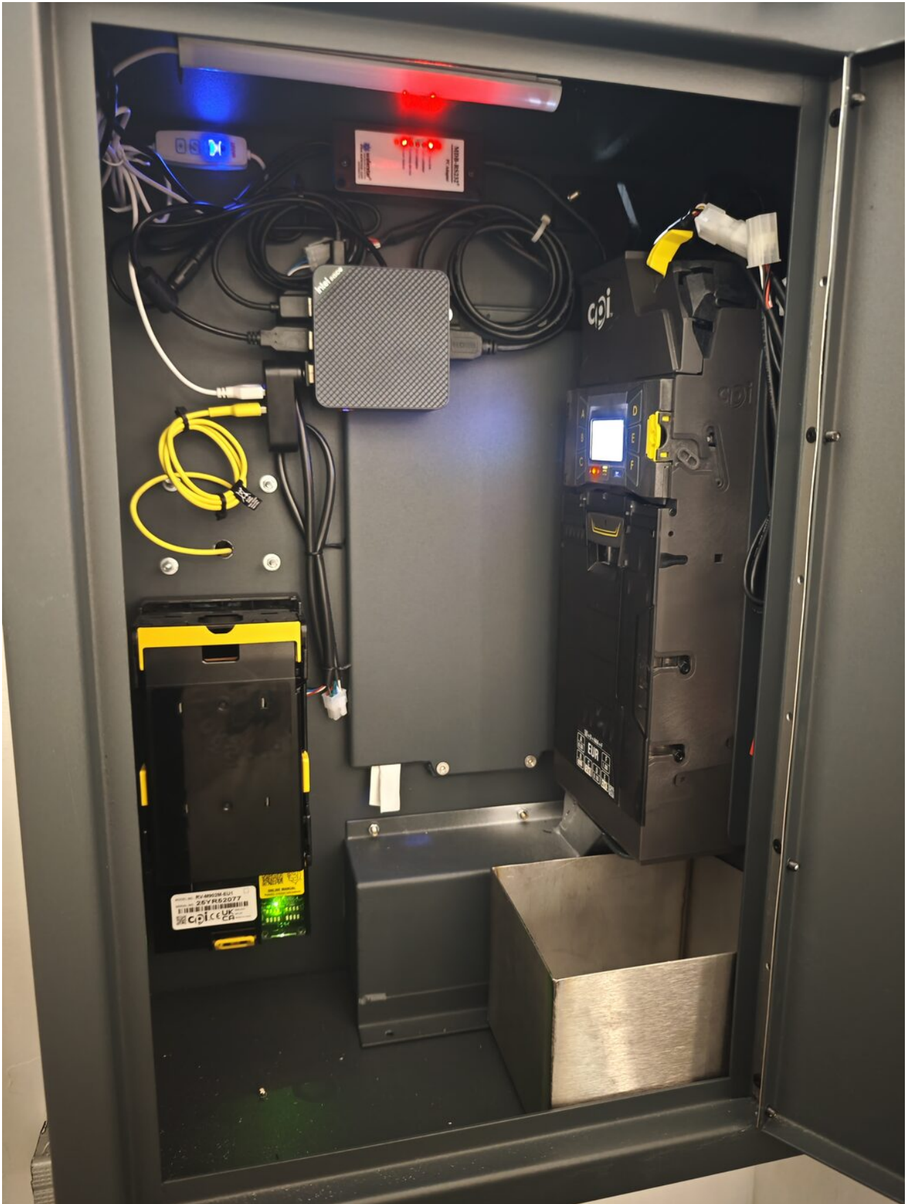
INTERIOR DA CAIXA · ILUMINAÇÃO DESLIGADA
